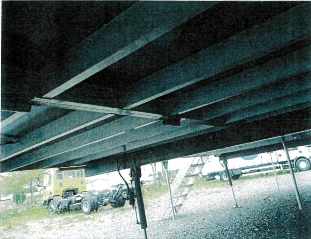
Dessous du Plancher : Bras repliables, structures aluminium, béquilles et vérins
